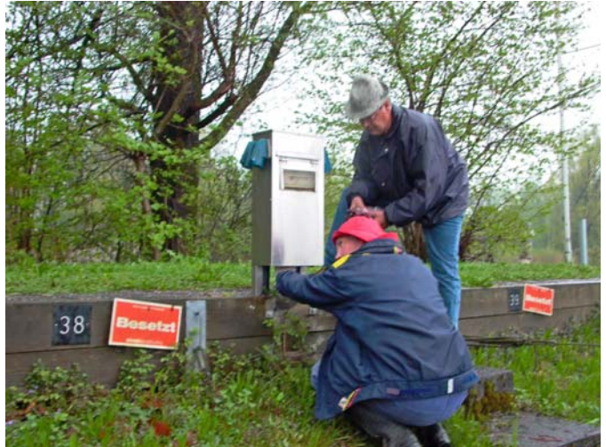
Inspektion der Elektrischen Infrastruktur.
