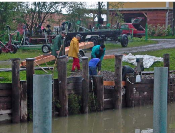
Fortschritt an der Nordmole.
