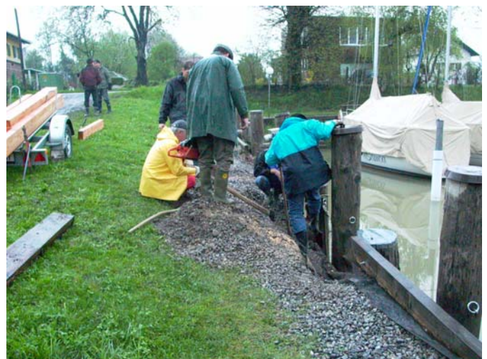
Reparatur der Nordmole.
